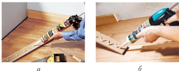
Рис. 31.2. Нанесення клею: а — краплями; б — змійкою
