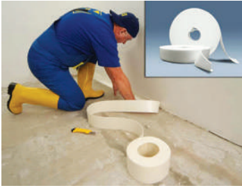
Рис. 17.2. Установлення демпферної стрічки до стіни й підлоги
