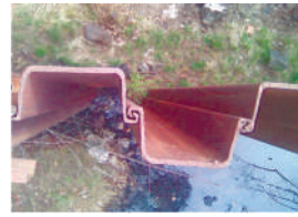
Рис. 46.1. Шпунтові з'єднання: а – дерев'яні; б – металеві
