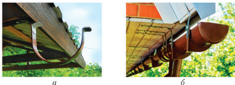
Рис. 18.7. Кріплення кронштейнів: а — плоского вигнутого до нижнього торця крокви; б — універсального до суцільного настилу
