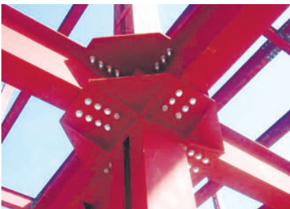
Рис. 41.2. Застосування фрикційних болтових з'єдань у металевих конструкціях
