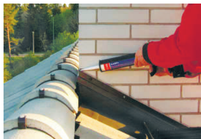
Рис. 32.6. Застосування замазки для покрівлі
